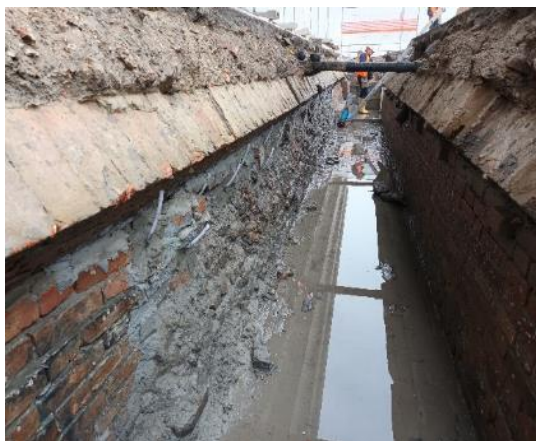
Risanamento dei cunicoli
