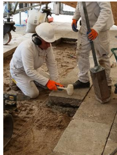
Nuova posa delle pavimentazioni
