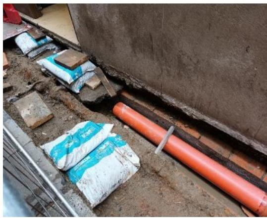
Riordino dei sottoservizi
