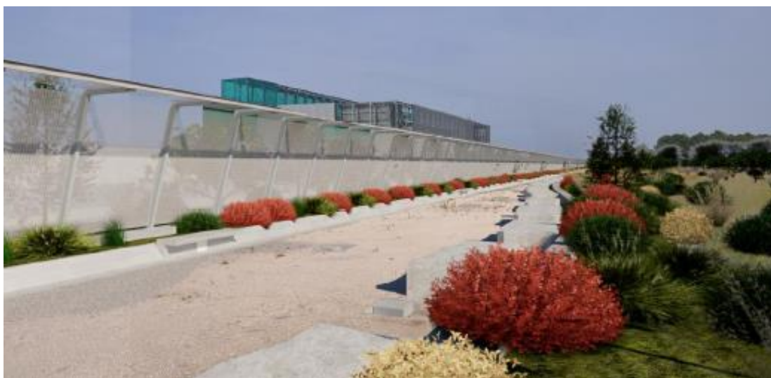
Vista con foto inserimento, lato area ecologica, il ricoprimento del cordolo con lastre in trachite sp.30cm.
