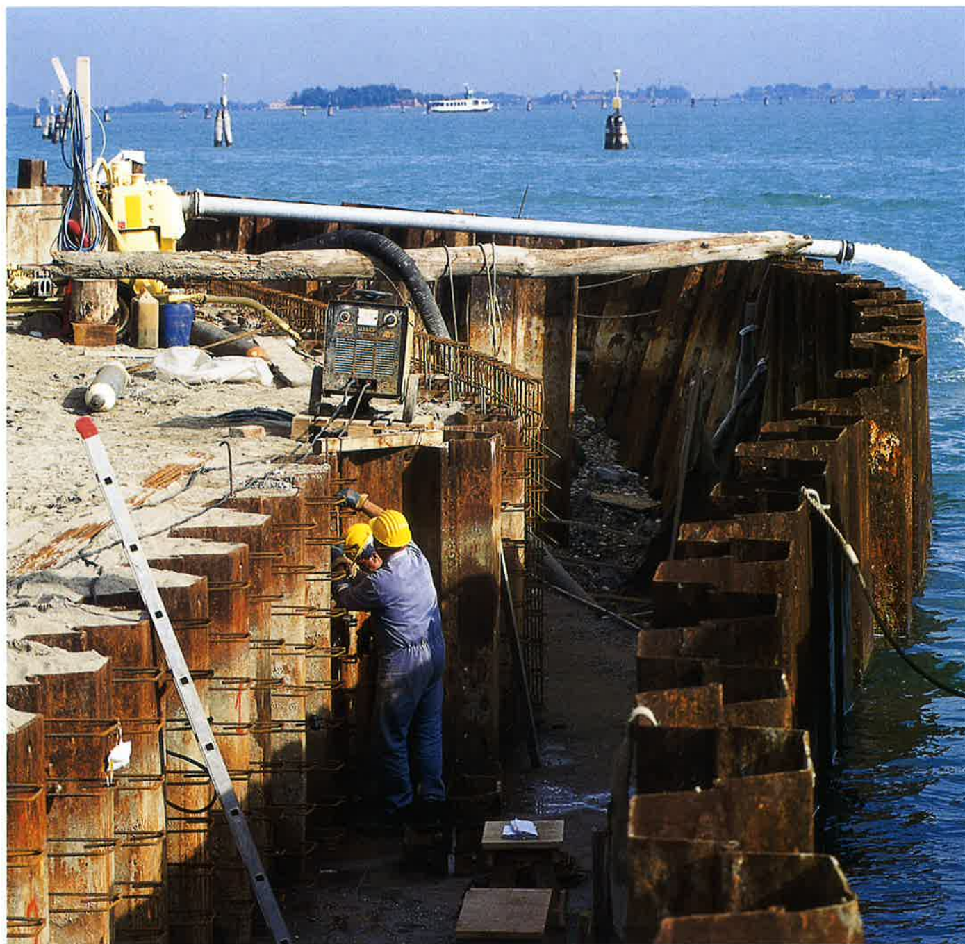
Interventi sul palancolato strutturale della nuova riva. Il palancolato visibile sulla destra è quello utilizzato per creare lo spazio ( tura ) dove lavorare all'asciutto
