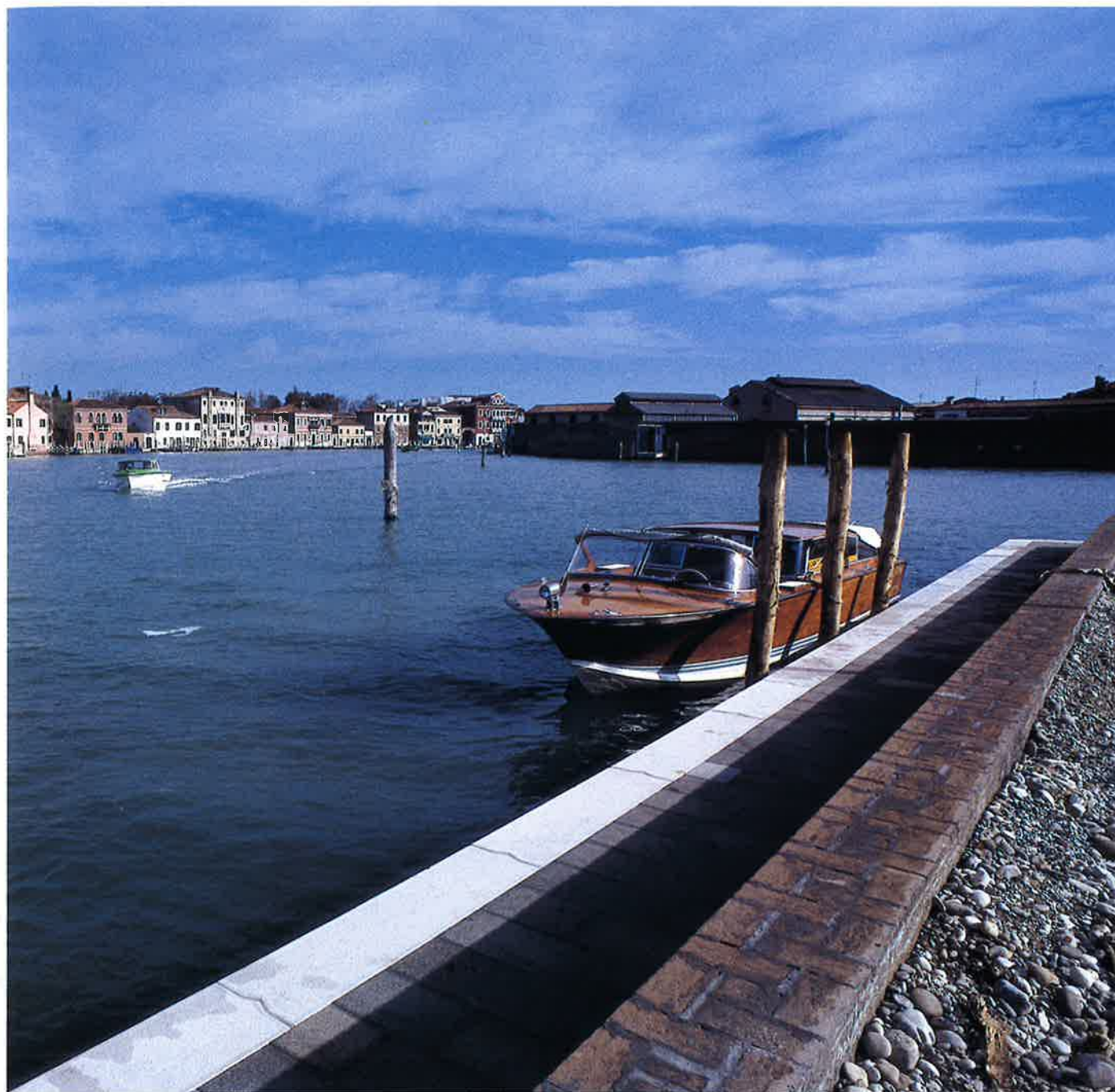
Un tratto della nuova riva. La foto mostra la riva a lavori quasi completati, quando restano da ultimare il cordolo sul muretto visibile in primo piano e la pavimentazione retrostante
