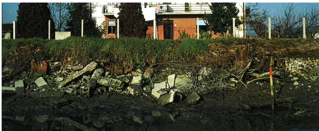
Sponda nord del Canale Saccagnana. Lo stesso tratto di riva prima e dopo i lavori
